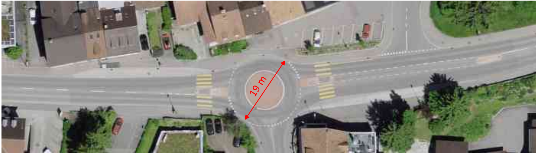
Minikreisverkehr Gelterkinden (Richtung Ormalingen) Durchmesser 19 Meter
